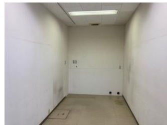
「北より見た倉庫内」
