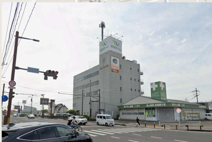
③ビル北西側交差点より
